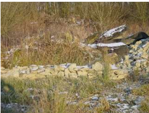
Mauern ohne Fugen, Trockenmauer mit Rooter Sandstein, Eschenbacher Moos
