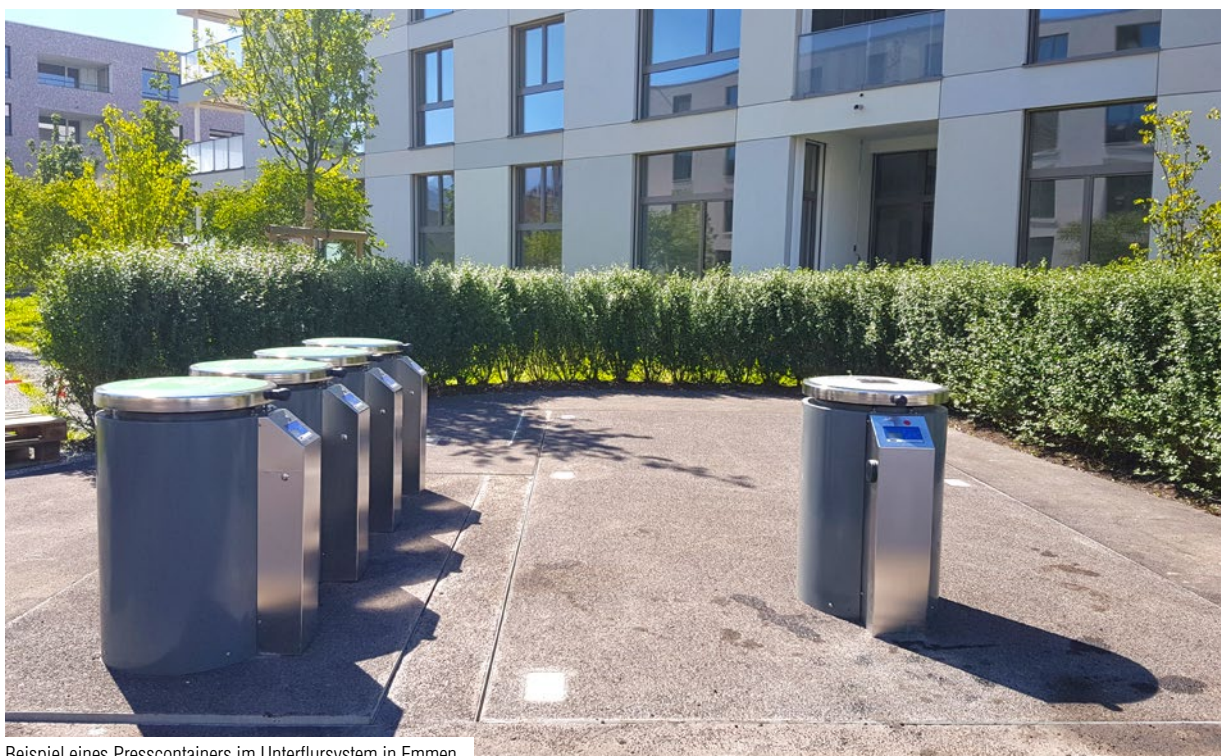
Beispiel eines Presscontainers im Unterflursystem in Emmen
